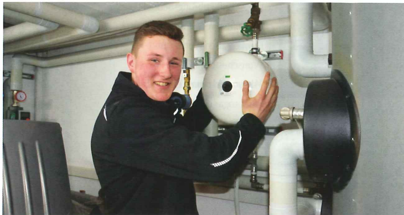
Noch ist er im ersten Ausbildungsjahr zum Anlagenmechaniker SHK. Aber dieses Ausdehnungsgefäß an der Pelletsheizung kann Fabian Grün schon selbstständig austauschen.
